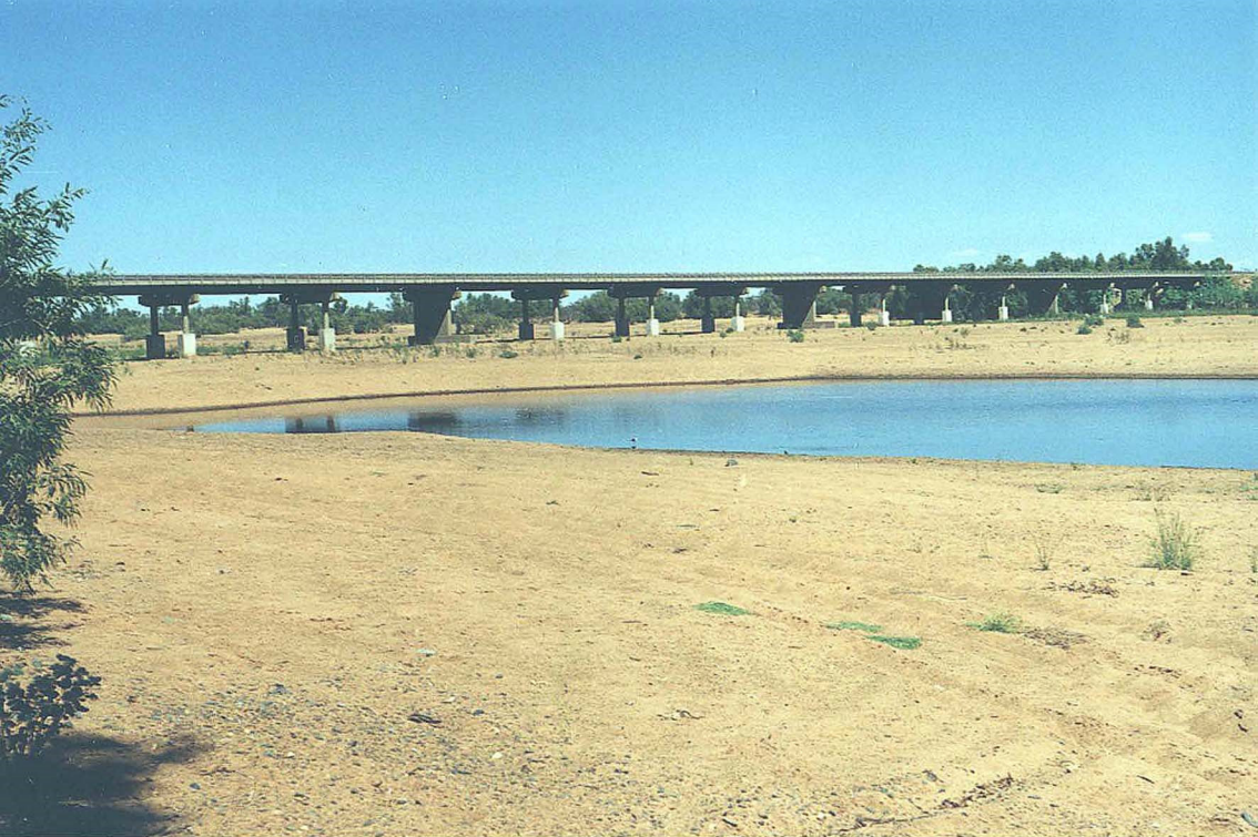
Brücke über den Yule River
