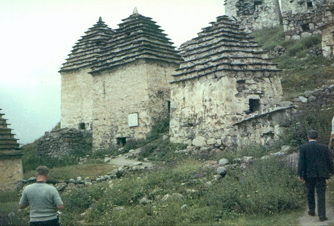
Die Totenhäuser bei Karmadon
